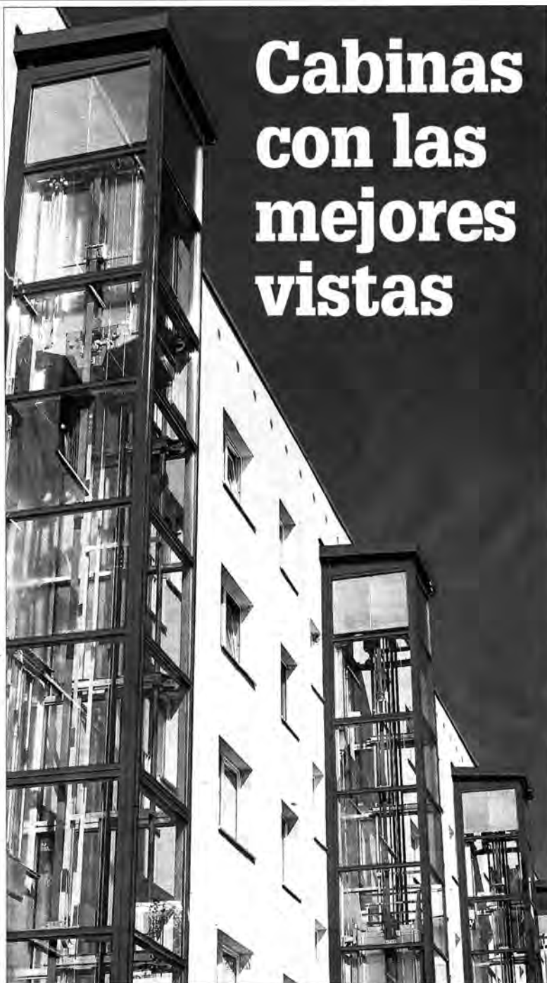
Un grupo de ascensores panorámicos en el exterior de un edificio. INFORMACIÓN
