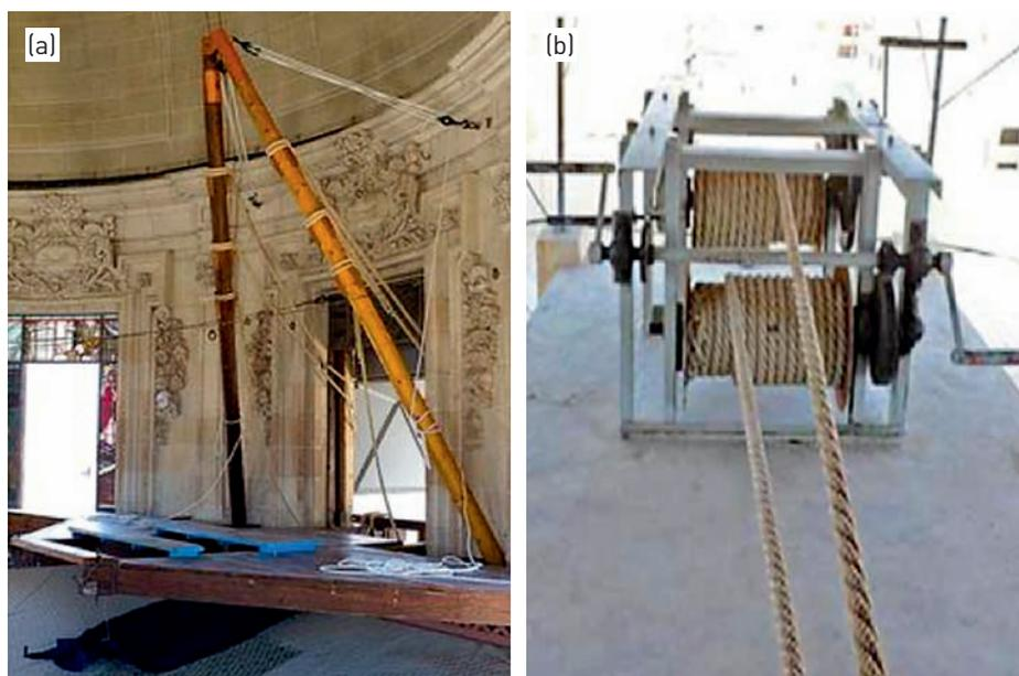
Figura 2. Cabria montada (a). Tornos de arrollamiento de las maromas de sustentación de aparatos aéreos (b).
