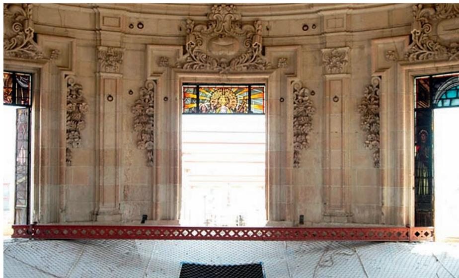
Figura 3. La jácena en su posición de trabajo, como vemos queda simplemente apoyada por sus extremos sobre el anillo toral, rebasando la cornisa.
