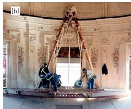
Figura 4. Vista de la plataforma apoyada en la jácena de madera (a). Ibidem en la actualidad sobre la jácena de acero (b).
